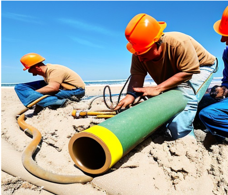
Figura 4. Instalación de fibra óptica en un segmento de tubería para diagnóstico de fugas.
